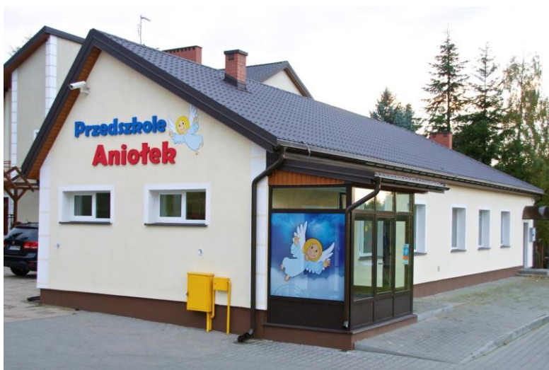
Fotografia 9. Budynek Przedszkola Aniołek w Szpetalu Górnym
