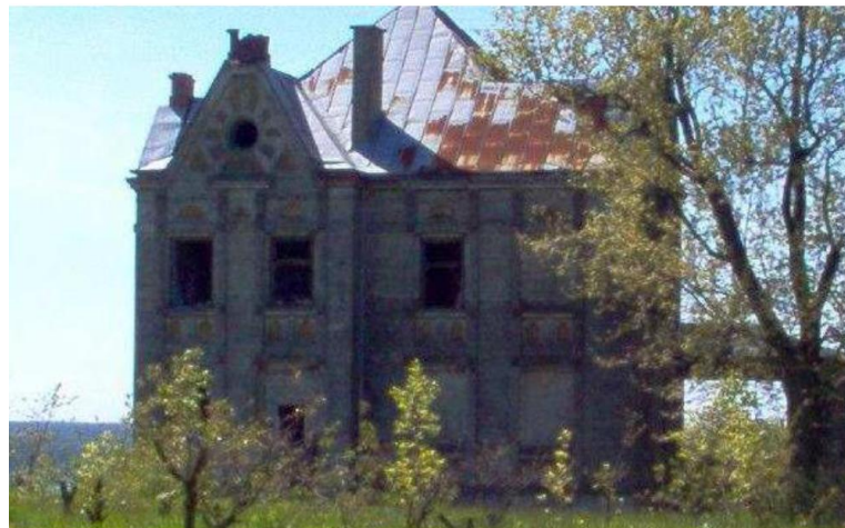
Fot. 6. Dwór w Zarzeczewie Starym
