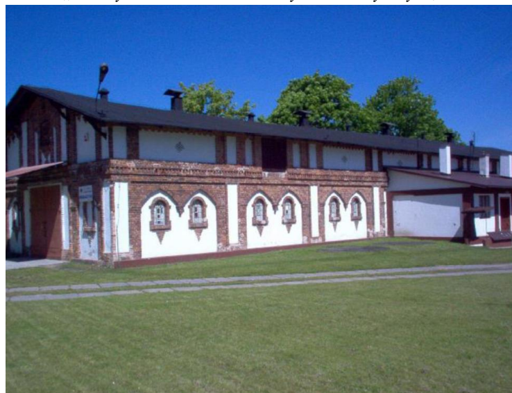
Fot. 7. Dwór i folwark w Szpetalu Górnym
